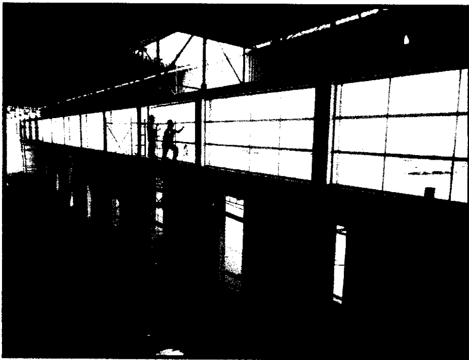
IMAGEN N° 04: INSTALACION DE VENTANAS DE ALUMINIO
